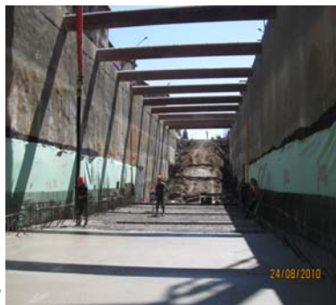
Фиг. 3. a/ Изграждане на конструкцията на МС 4-II по открит способ в котлован с пилотно укрепване и армиран торкрет; b/ Изграждане на тунел в участък МС 2-II - МС 3-II в котлован, укрепен с шлицови стени
