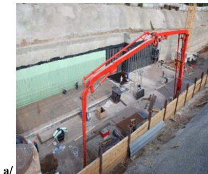
Фиг. 3. a/ Изграждане на конструкцията на МС 4-II по открит способ в котлован с пилотно укрепване и армиран торкрет; b/ Изграждане на тунел в участък МС 2-II - МС 3-II в котлован, укрепен с шлицови стени
