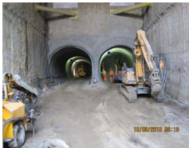
Фиг. 4. a/ Изграждане на еднопътни тунели b/ Строителство на станция „Младост 3” под бул. А. Сахаров в участъка „МС Младост 1 – МС Младост 3”
