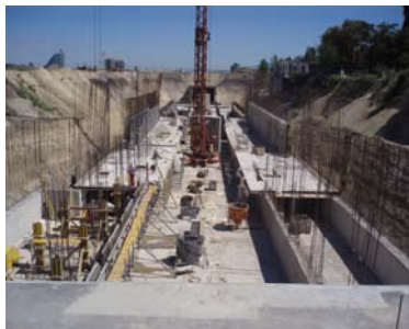
Фиг. 4. a/ Изграждане на еднопътни тунели b/ Строителство на станция „Младост 3” под бул. А. Сахаров в участъка „МС Младост 1 – МС Младост 3”
